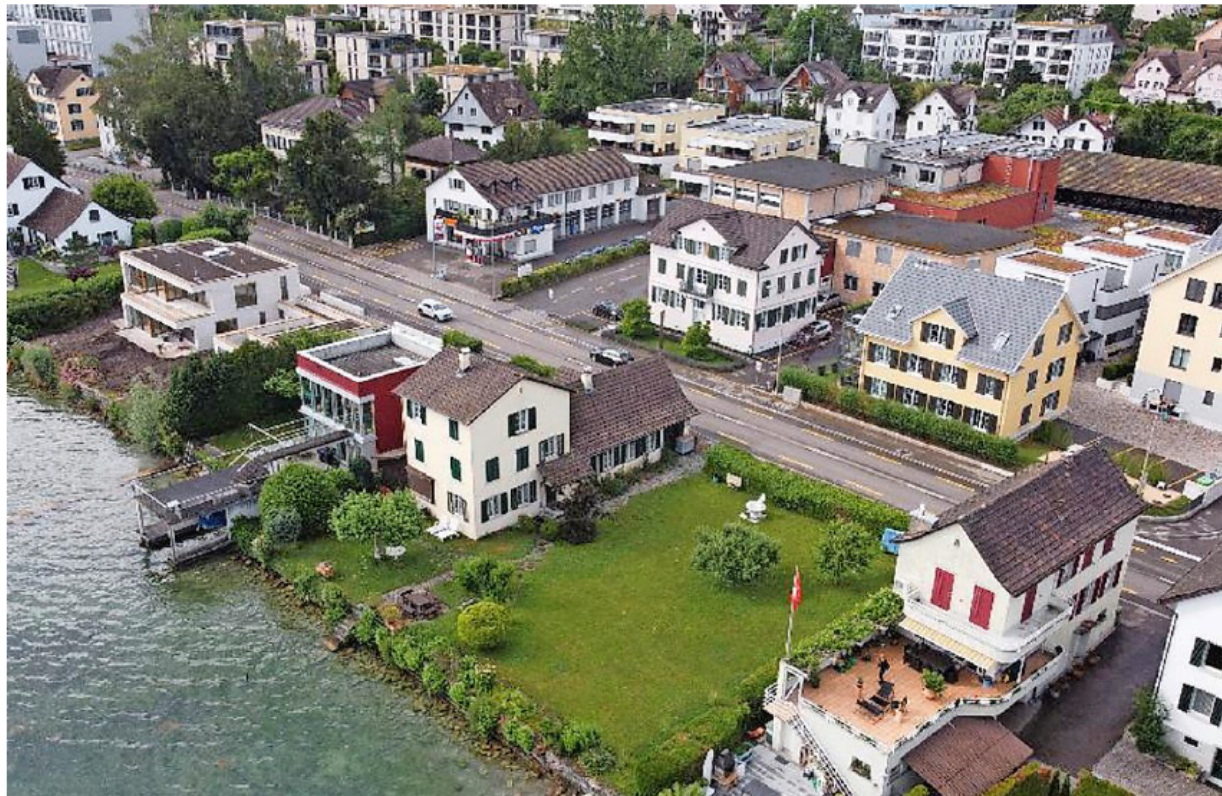
1112 Quadratmeter gross ist das umstrittene Grundstück – hier das dritte Gebäude von rechts im Bild. Foto: Gemeinde Männedorf
